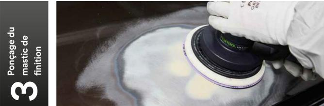
3 Ponçage du mastic de finition
